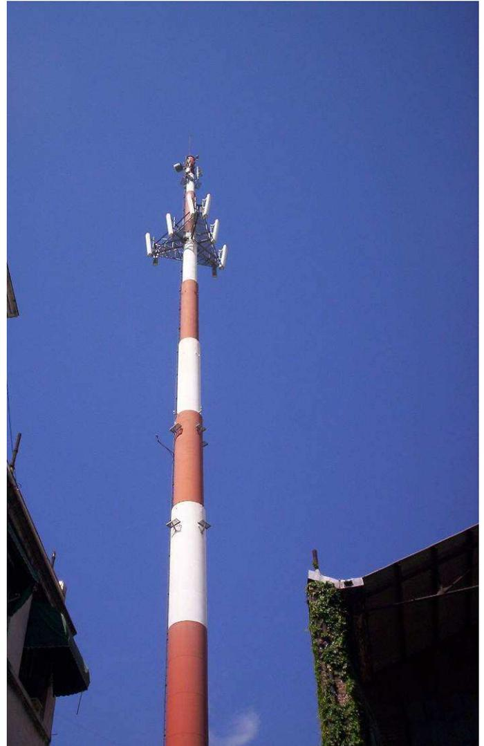
Foto II: Antenas montadas en Torre "monoposte"
